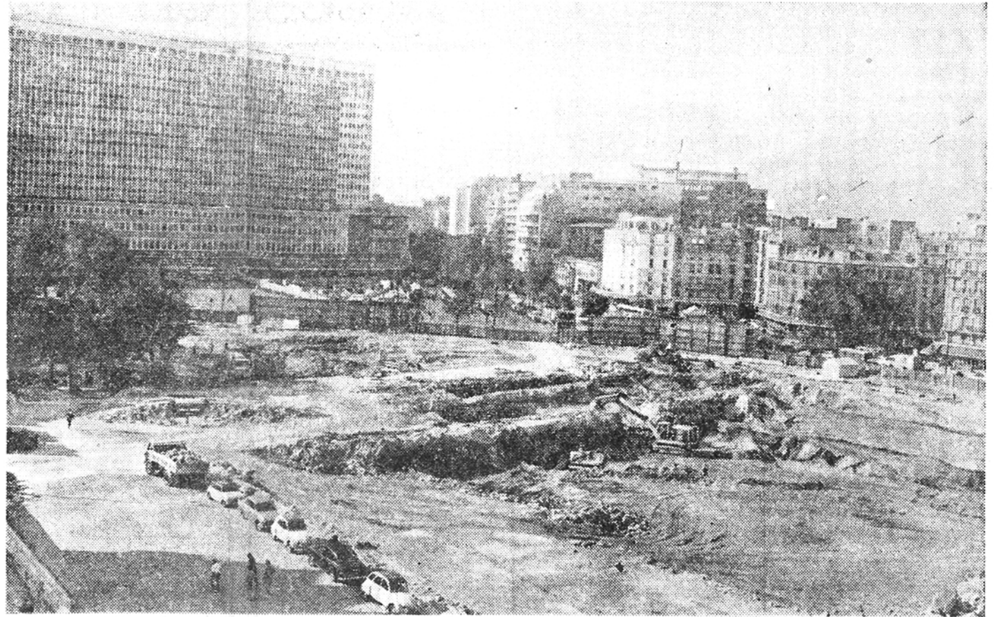
Sur le vaste espace libéré par la démolition de l'ancienne gare Montparnasse, les terrassements ont commencé : on creuse les fondations de ce qui sera, dans trois ans, l'ensemble « Tour Maine-Montparnasse ».
