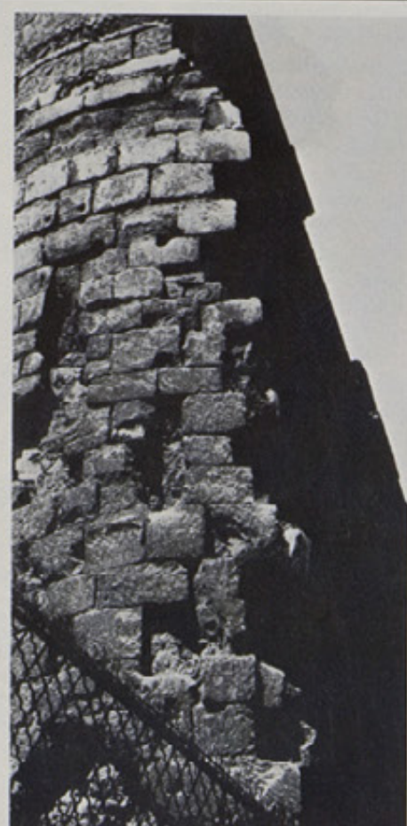
Mur d'enceinte de Philippe Auguste (13 e siècle) rue Charlemagne bordant la rue des Jardins-Saint-Paul.
