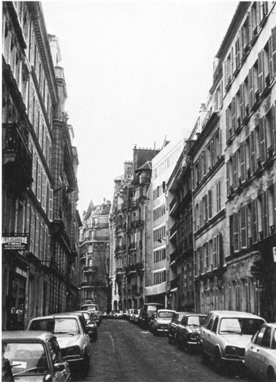
Rue de Fleurus, le constructeur a réalisé un bandeau à l'alignement de fait de la voie mais retraité légèrement — et en biais — son bâtiment.
