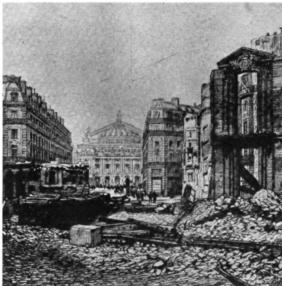
La trouée de l'avenue de l'Opéra à la fin des travaux, en 1877
