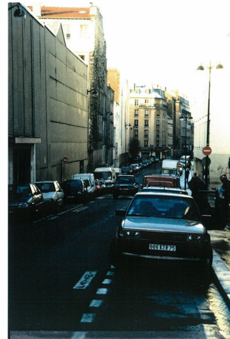
Murs pignon de la rue de la Fontaine-au-Roi
