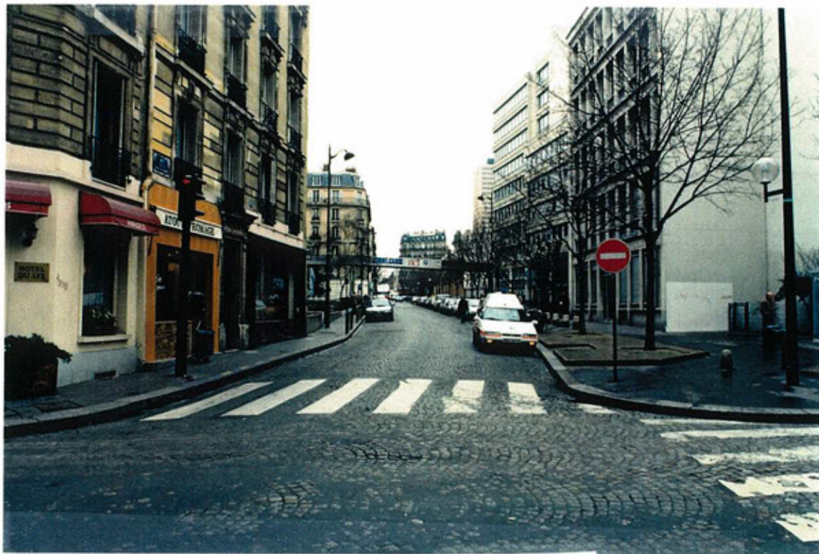
Rue de la Procession : de la rue Dutot vers la rue Falguière
