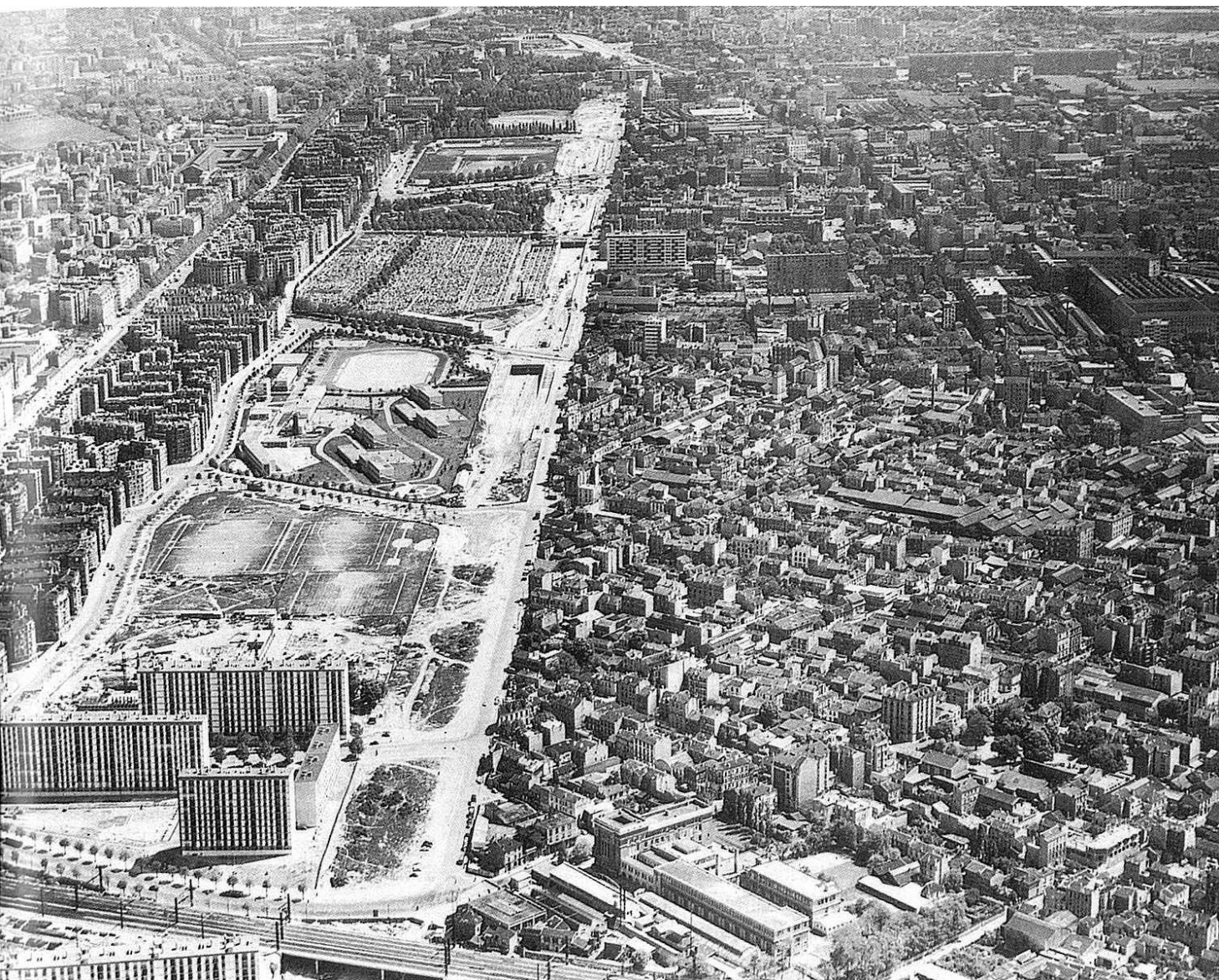
ci-dessus: Le boulevard périphérique en construction dans le secteur Sud.
