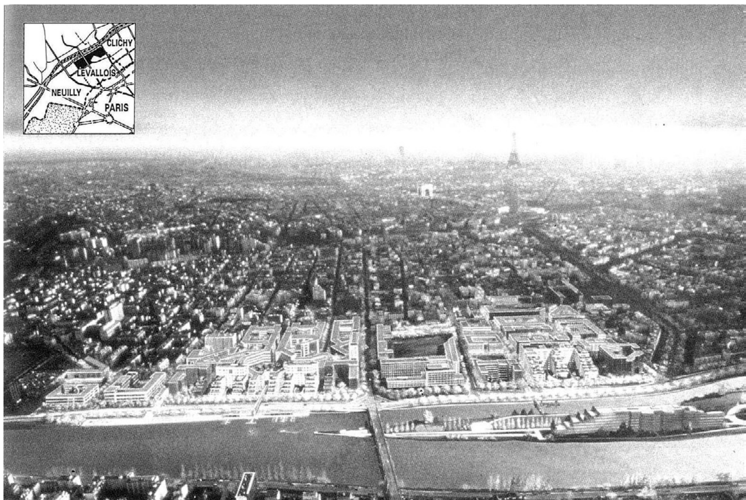
L'opération Levallois-la Seine à Levallois Perret: la plus grande ZAC de l'Ile-de-France (50 ha environ).
