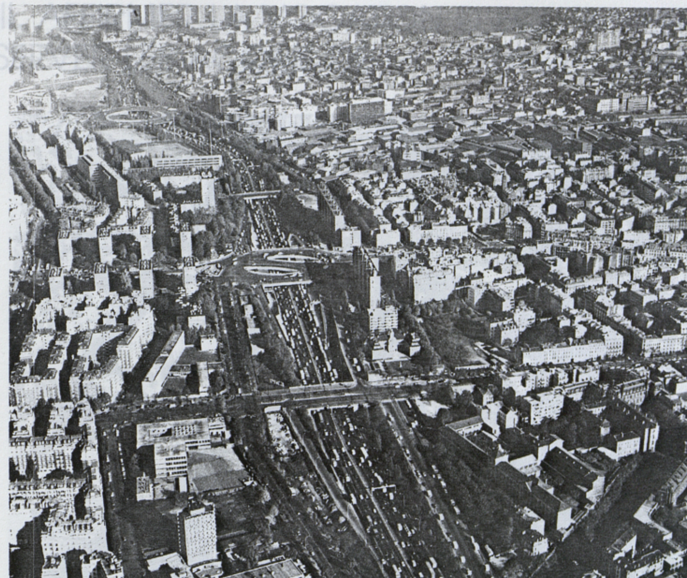
Porte de Vincennes : le boulevard périphérique tranche dans le tissu urbain
